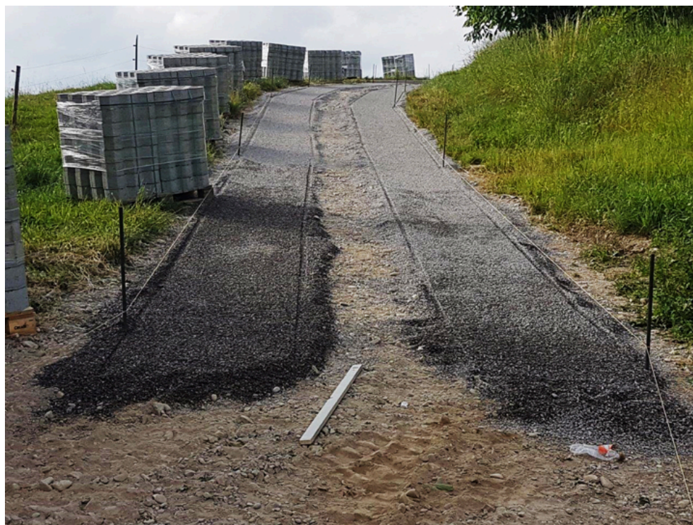
Préparation de la pose des dalles alvéolées. Un profil négatif permet d'évacuer l'eau vers la gouttière centrale.
