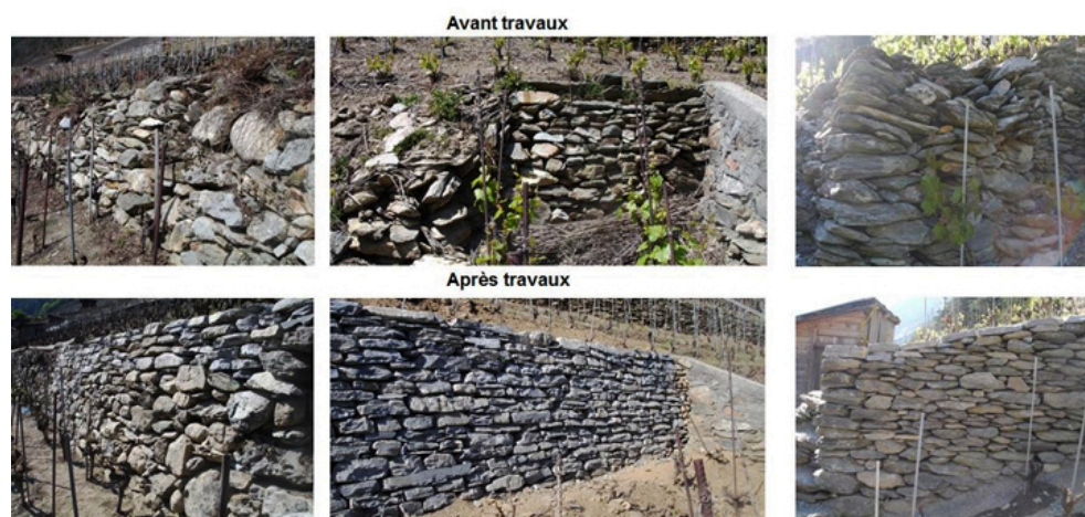
Exemples de réalisation avant et après travaux
